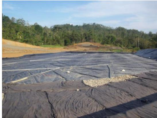
**Fotografía 7.4.4-4** Colocación de geosintéticos y tuberías.
