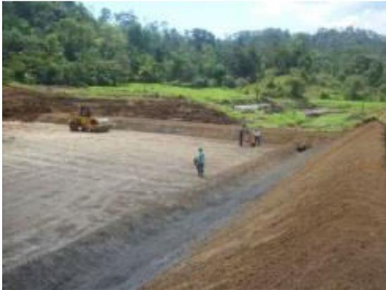
**Fotografía 7.4.4-3** Compactación del terreno en las celdas de trabajo
