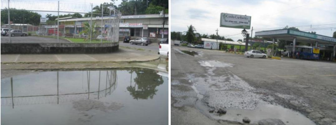
**Fotografías 7.4.2-3** Secciones sobre la Ruta N°32 sin drenajes de agua pluvial (época lluviosa).
